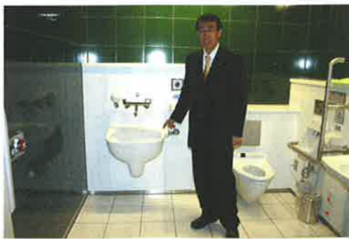
地下鉄七隈線 天神南駅
